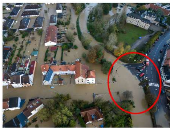
Hostellerie de la Rivière 07/11/2023: proche du PPRI
